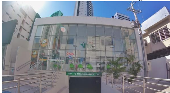
Figura 1: Fachada do Hospital Veterinário Harmonia – Unidade Boa Viagem.
