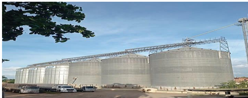
Figura2. Silos de armazenagem de milho,Carpina-PE, 2021.
