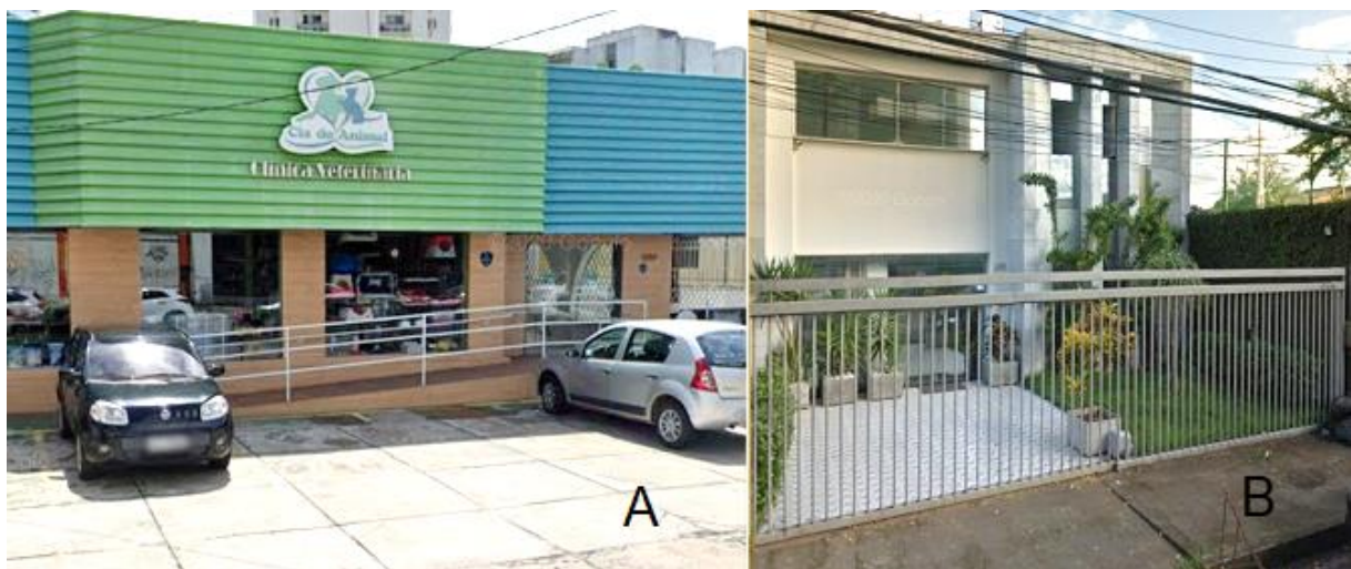
Figura 1. Vista frontal da clínica veterinária Cia do Animal, onde ficava instalada a CORE – Oncologia Veterinária, no bairro do Rosarinho, Recife-PE, até 26 de setembro de 2020 (A). Vista frontal da nova instalação da clínica CORE – Oncologia Veterinária, no bairro da Madalena, Recife-PE (B).
