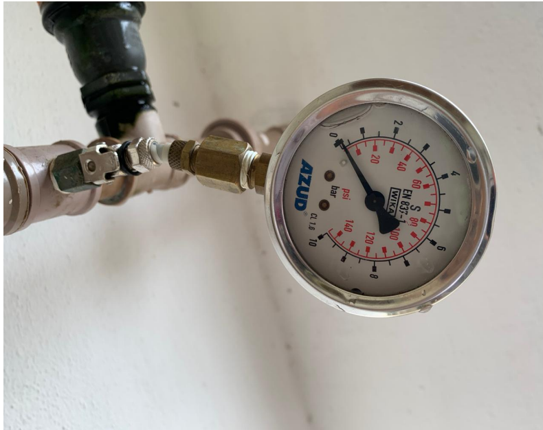
Figura 36 Instalação do manômetro para aferição da pressão.
