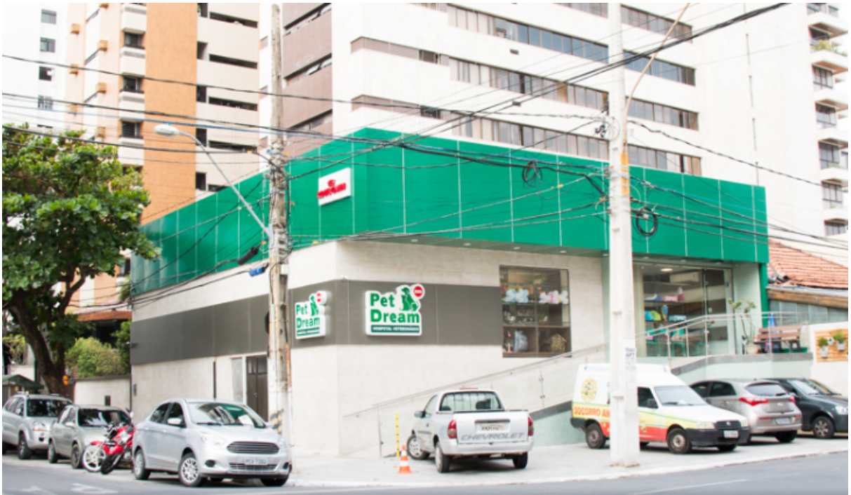
Figura 1. Hospital Veterinário Pet Dream - Boa Viagem
