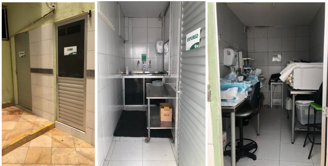
Figura 12, 13 e 14 – Portas de acesso ao expurgo e CME (12); expurgo (13); CME (14).
