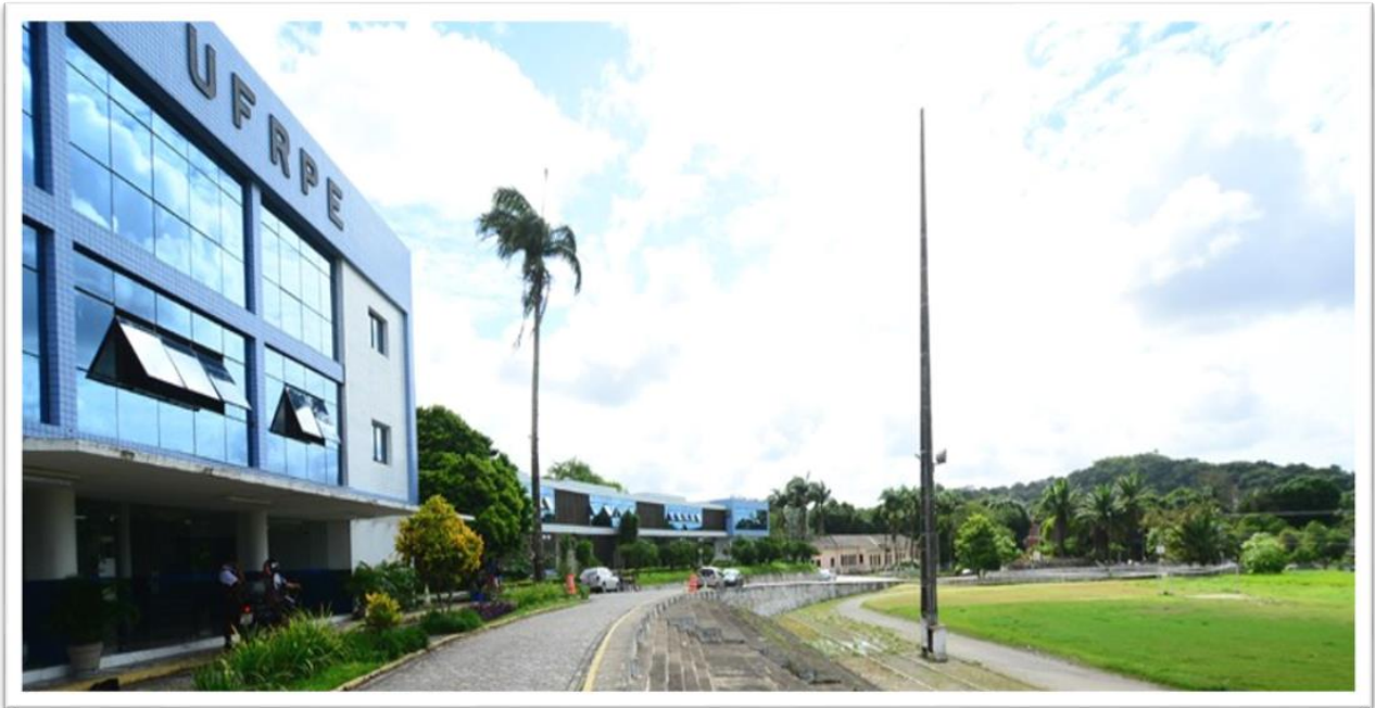
Figura 1. Sede da Universidade Federal Rural de Pernambuco. Recife - PE
