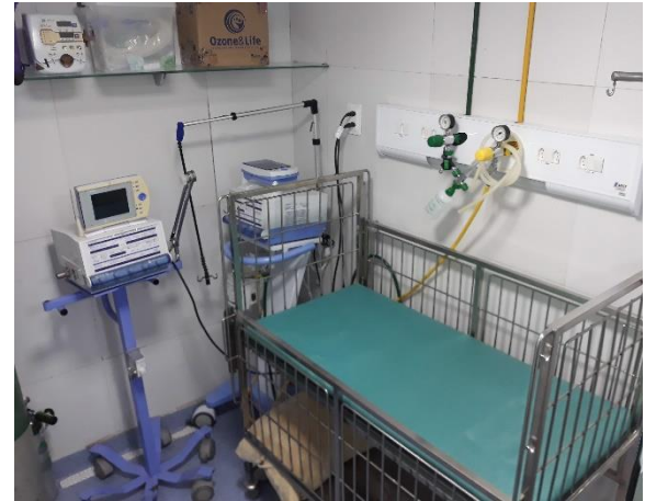
Figura 10 - Unidade de terapia intensiva com saída de gases medicinais e oxigênio, bomba de infusão e ventilador mecânico. Hospital PetDream. Fonte: VILARIM, 2021.
