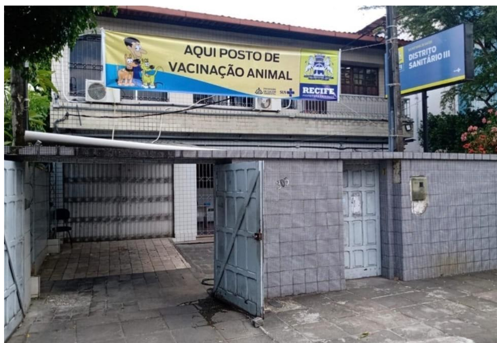
Figura 2 - Fachada do Distrito Sanitário III.
