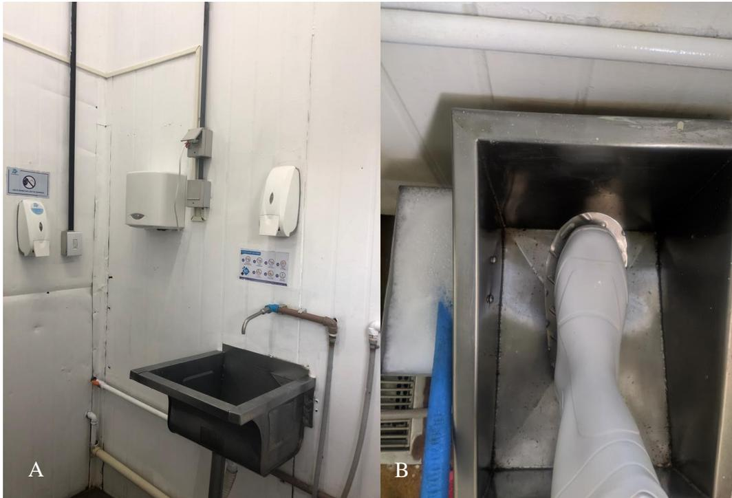
**Figura 3:** Barreira sanitária I. **A)** Pia para lavagem das mãos com acionamento por pedal; **B)** Lava botas.
