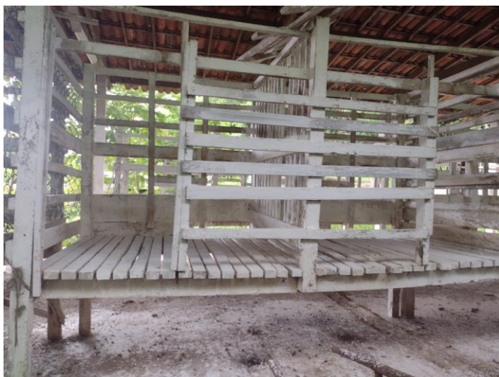
Figura 5: Baias após utilização de cal virgem. Fonte: Arquivo pessoal.
