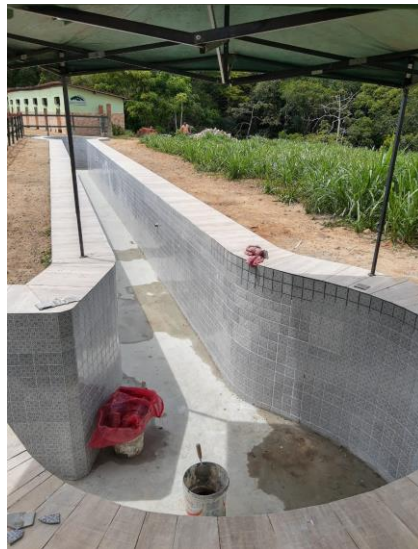
Figura 2: Piscina de treinamento em construção
