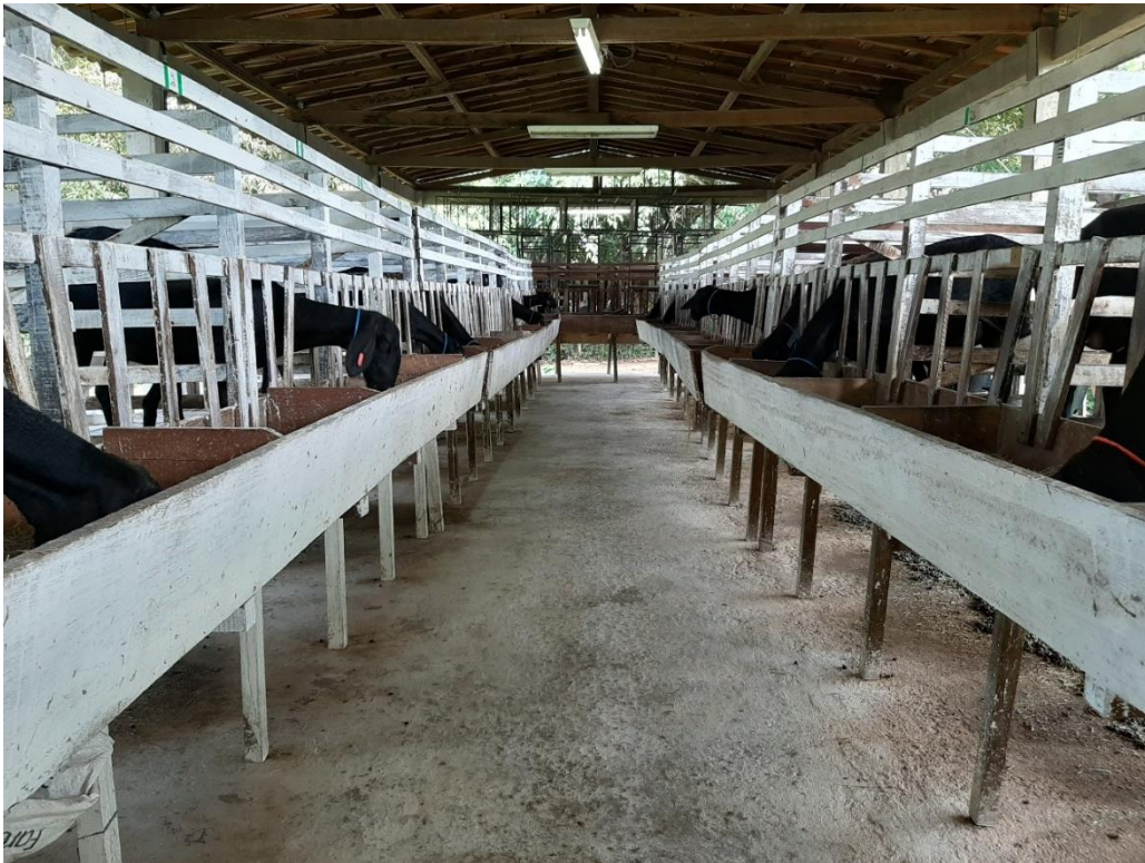
Figura 2 – Vista interna do galpão principal do setor de ovinos do Departamento de Zootecnia – UFRPE/SEDE.
