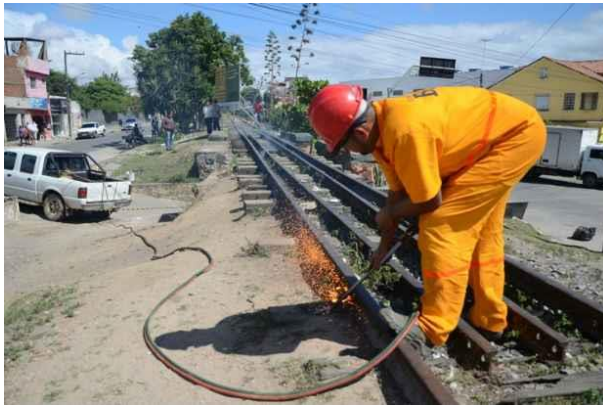
Figura 14: Retirada de parte da linha férrea no centro de Gravatá
