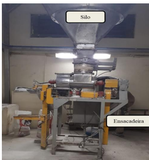
Figura 26. Ensacadora a válvula com silo. Fonte: Acervo pessoal.
