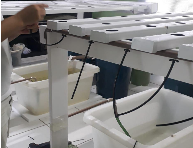
Figura 30. Instalação dos injetores no tubo de distribuição.
