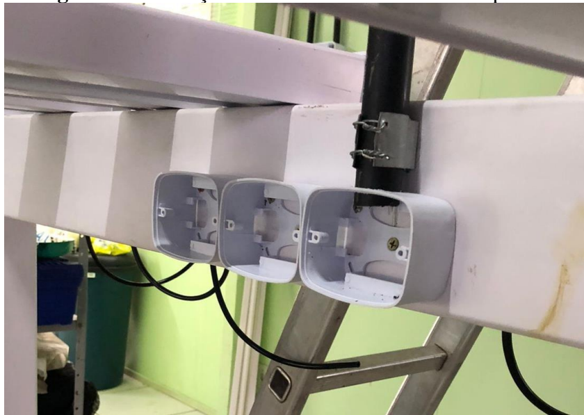
Figura 34. instalação de tomadas na bancada hidropônica.
