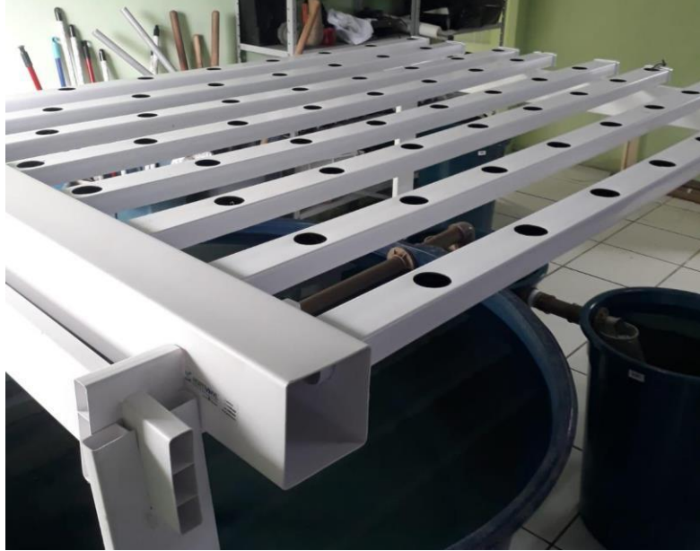
Figura 26. Bancada hidropônica em processo de montagem.
