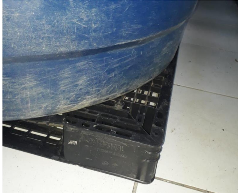
Figura 15. Tanque em cima de pallet de plástico utilizado como suporte.
