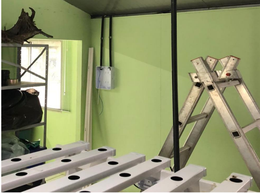
Figura 35. instalação do painel de controle de energia e de tomadas acima da bancada.
