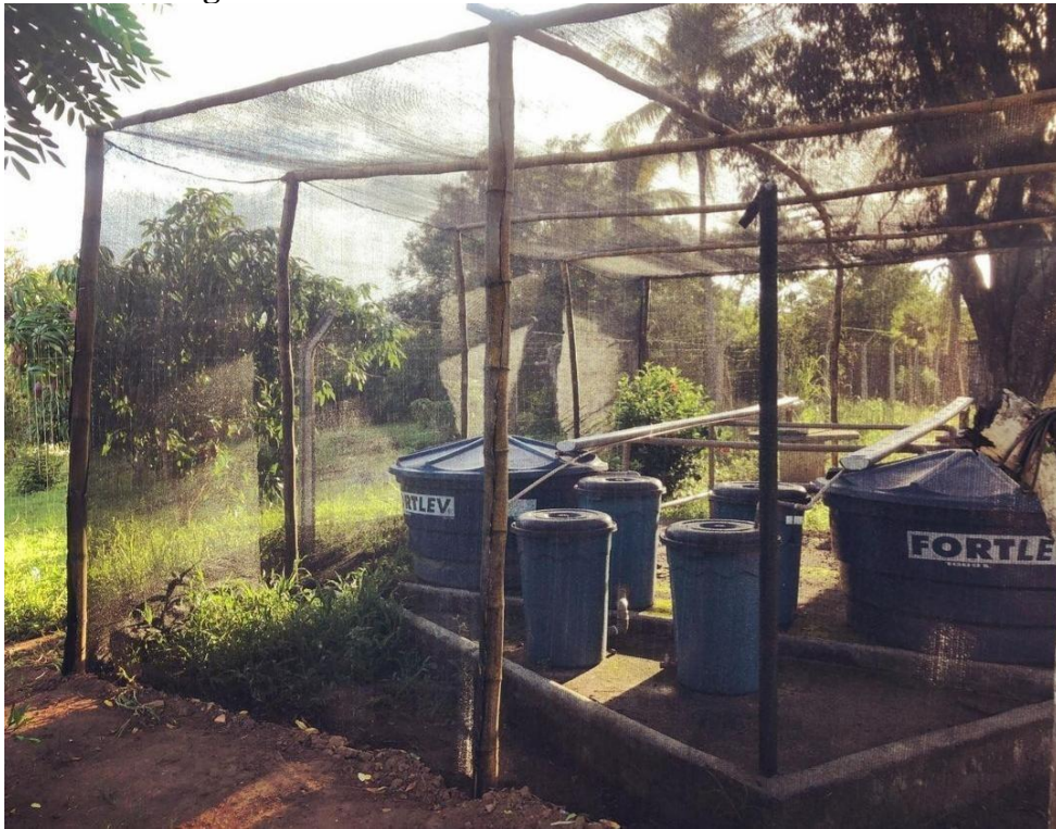
Figura 5. Estrutura montada com bambu e sombrite.
