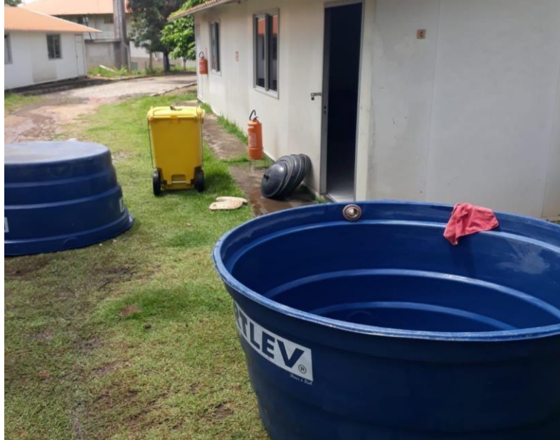
Figura 14. Higienização dos tanques para montagem do sistema.
