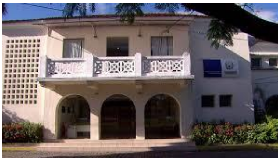
Figura 1: Prédio Sede da ADAGRO. Fonte Google imagens.
