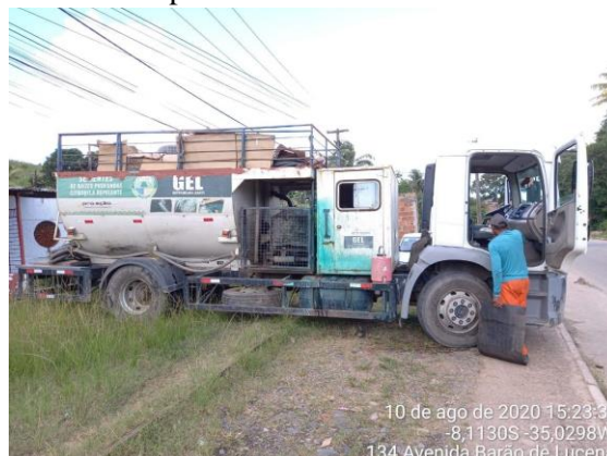
Figura 5: Pré etapa verificação e mistura do produto no caminhão.
