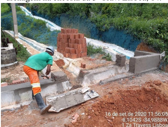
Figura 3: Execução de parte do sistema de drenagem na encosta da 3ª Trav. Lisboa, 14.
