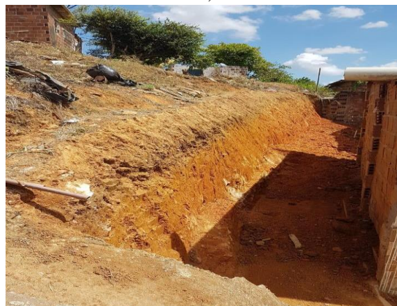
Figura 2: Regularização da encosta na 3ª Trav. Lisboa, 14.
