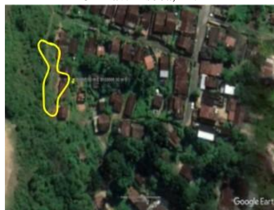
Figura 1: Localização via satélite da encosta na 3ª Trav. Lisboa, 14.
