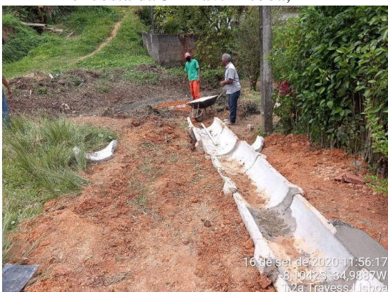
Figura 4: Execução da destinação de águas na encosta da 3ª Trav. Lisboa, 14
