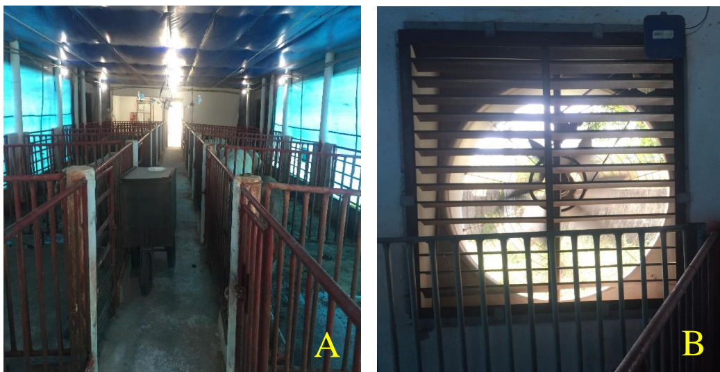
Figura 2. Sistema de pressão negativa. Galpão dos reprodutores (A) e equipamento (B)
