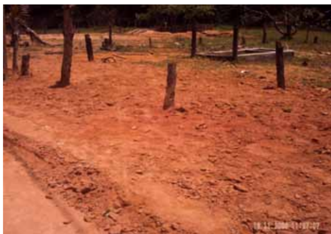
Figura 3. Retirada da cobertura vegetal. Foto: a autora.
