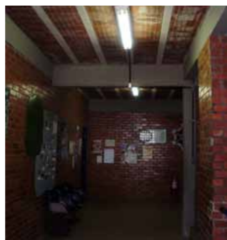
Figura 1. Iluminação diurna no corredor do bloco acadêmico 1
