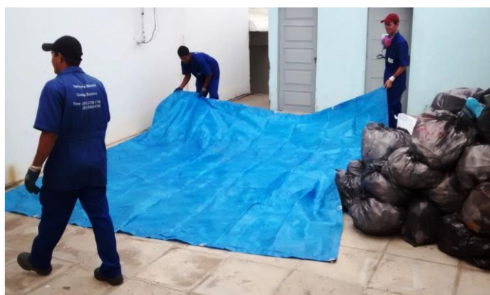
Figura 11. Colocação de lona para despejo dos resíduos.
