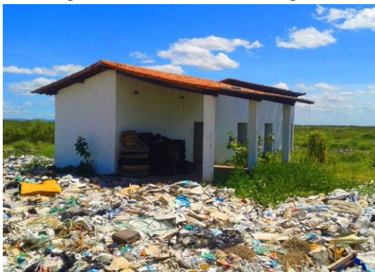
Figura 3 . Galpão de acondicionamento dos pneus inseríveis
