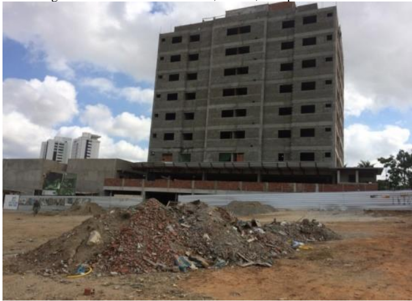
Figura 12. Av. Antônio Vilarim, Catolé, Campina Grande-PB.
