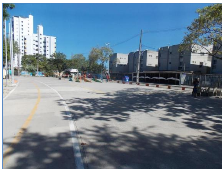
Figura 5. Praça de eventos com, impermeabilização do solo, vegetação exótica e expansão imobiliária.
