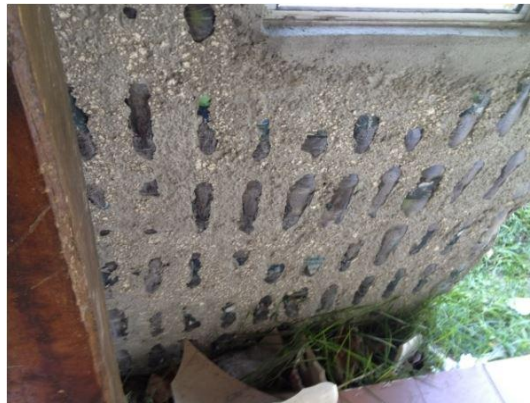
Figura 7 – Uso de garrafas pet como enchimento de paredes - exemplo 02
