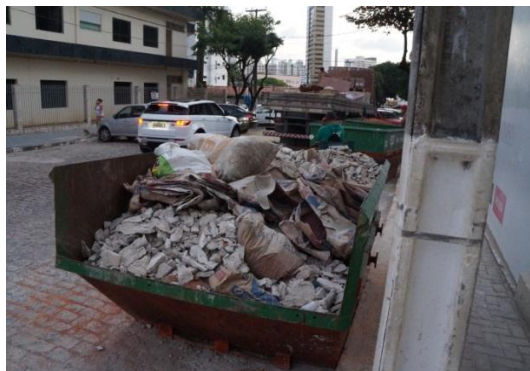
Figura 1 – Caçamba de resíduos de classe A
