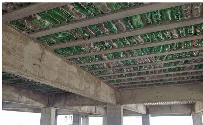
Figura 5 – Uso de garrafas pet como enchimento de lajes
