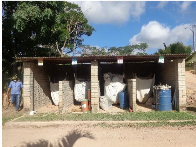
Figura 9 - Baias construídas na ETE Curado com o tijolo produzido
