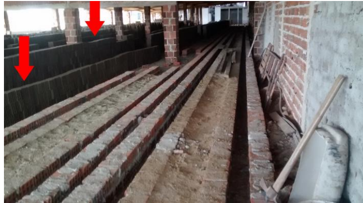
Figura 7- Blocos cerâmicos no galpão de secagem artificial (detalhe para os blocos empilhados em cima de leiras)
