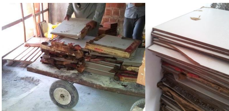
Figura 2:Trincas por choques mecânicos
