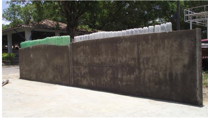
Figura 6 – Uso de garrafas pet como enchimento de paredes - exemplo 01
