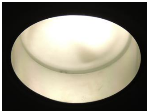
Figura 12 - Tipo de luminária para lâmpada PLC.
