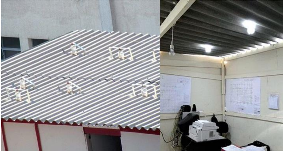
Figura 2 – Iluminação zenital com garrafas pets
