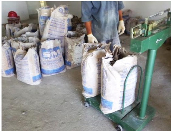
Figura 1 – Pesagem dos resíduos na obra.
