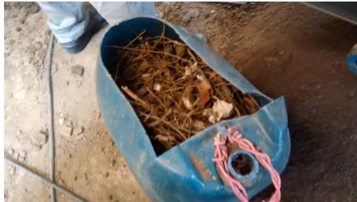
Figura 5 - Raízes de plantas retiradas na inspeção entre os laminadores
