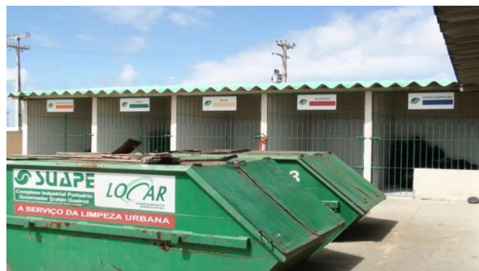
Figura 1 – Central de Triagem de Resíduos de Suape. – CTRS.
