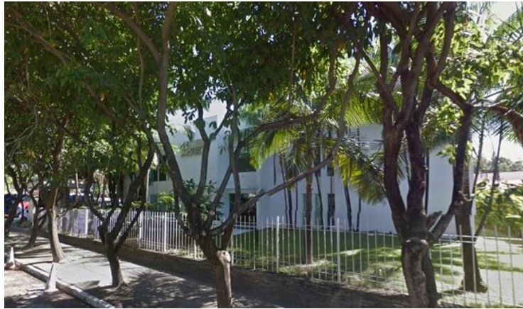
Figura 10 - Visão geral da edificação
