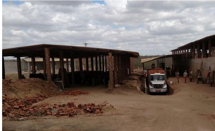
Figura 9 – Peças quebradas depositadas no solo.
