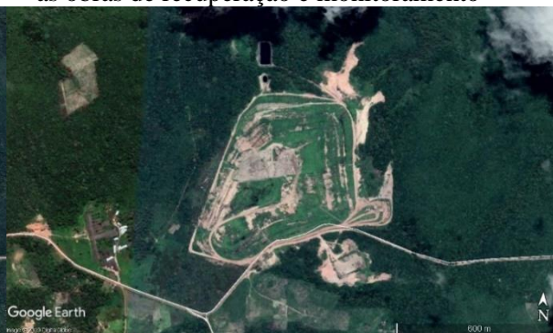
Figura 5. Vista aérea do aterro após iniciadas as obras de recuperação e monitoramento
