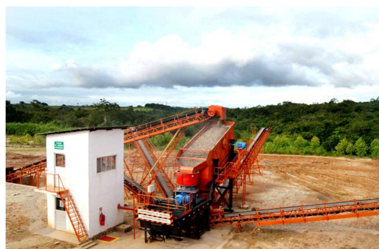
(b) Britagem dos resíduos da construção civil (RCC).
