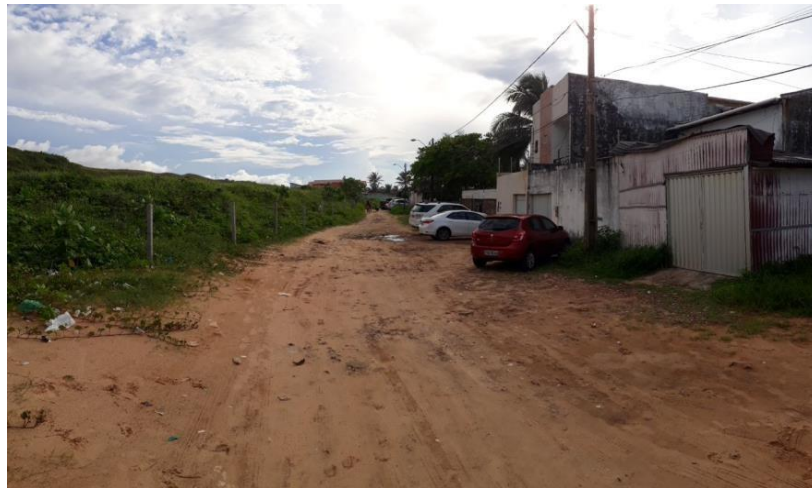
Figura 2. Local proposto para utilização do agregado reciclado como pavimentação
