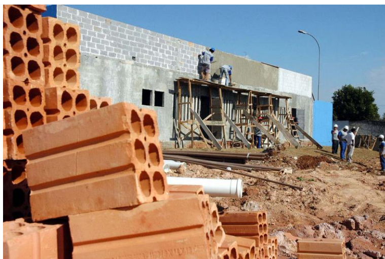
Figura 1. Resíduos da construção civil e os colaboradores
