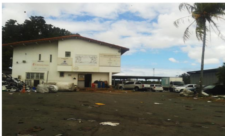
Figura 4: Fachada da cooperativa
