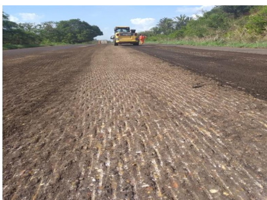
Figura 1. Pavimento após a técnica de fresagem no km 100 da BR-316, Caxias – MA.
