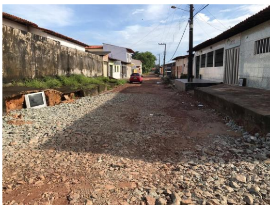
Figura 3. Camada de revestimento asfáltica deteriorada (Bairro Maiobão, Paço do Lumiar – MA).
