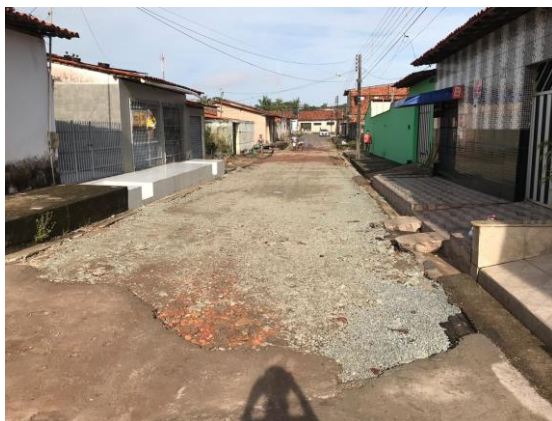
Figura 3. Camada de revestimento asfáltica deteriorada (Bairro Maiobão, Paço do Lumiar – MA).
