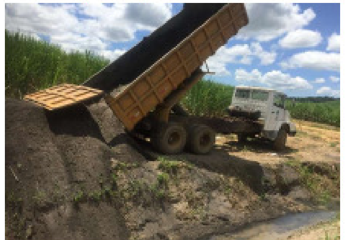
Areia para cobertura do tubo dreno
