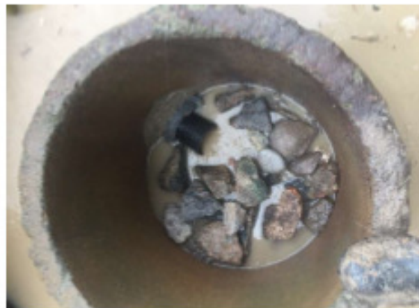
Poço de Visita
