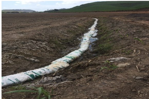
Figura 21:Dreno fechado com Bambu
