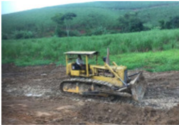
Sistematização do Solo – trator esteira
