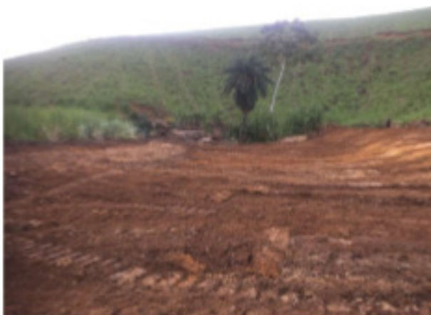
Área pós instalação do sistema
