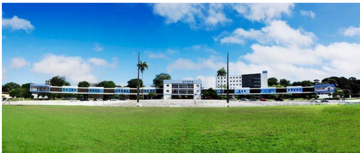
Figura 3: Vista frontal do prédio central do campus sede da UFRPE – Dois Irmãos, Recife– PE
