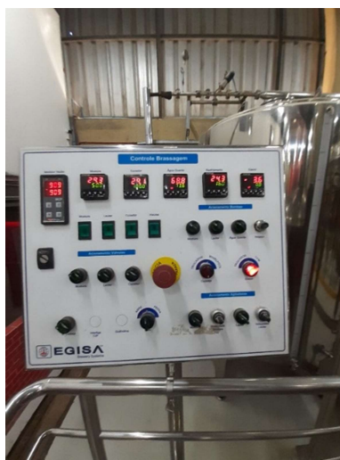
Figura 8. Painel de controle da brasagem.
