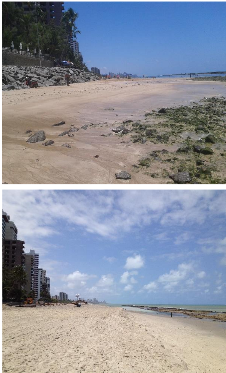
Figura 2: Praia de Piedade, local onde passou pelo processo de engorda. a) imagem corresponde a Pré-engorda e b) a Pós engorda. Fonte: Clélia Rocha.
