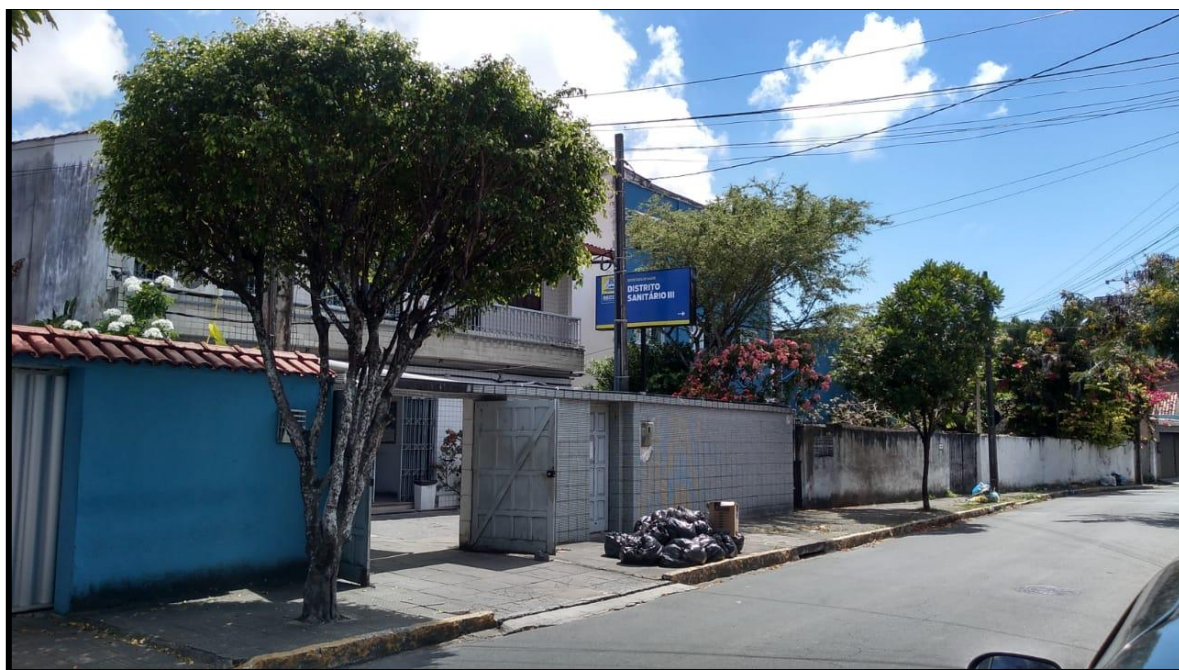
Figura 1. Fachada do Distrito Sanitário III
