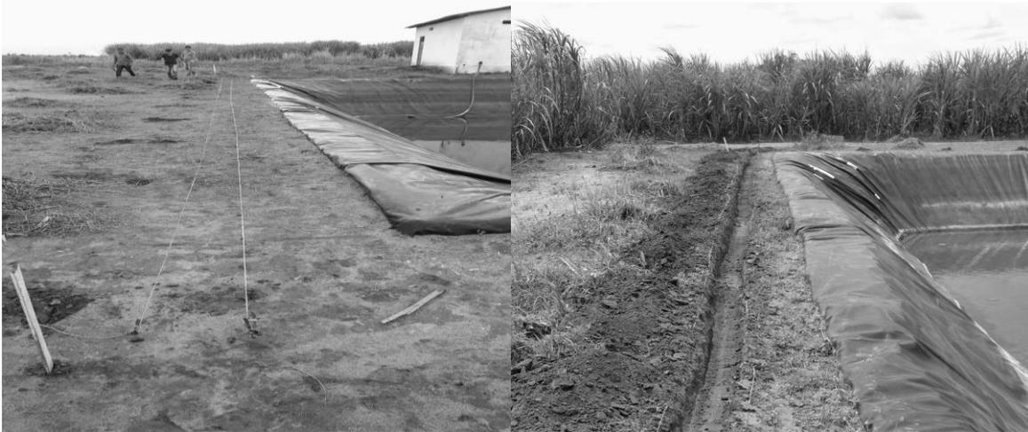
**Figura 7.** Valas para conter assoreamento e aberturas no solo para construção de uma cerca.
