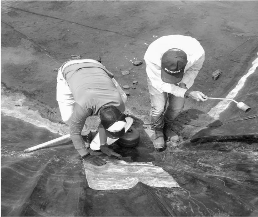
**Figura 10.** Reparo da geomanta com manta asfáltica aluminizada
