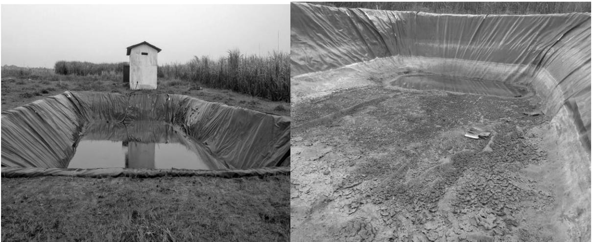
**Figura 11.** Tanque antes de reparo da geomanta e secamento e posterior limpeza de resíduos
