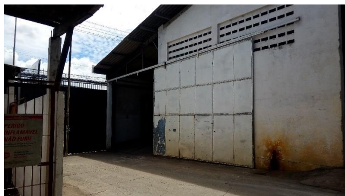
Figura 51. Entrada do galpão de produto acabado. Fonte: Arquivo pessoal.
