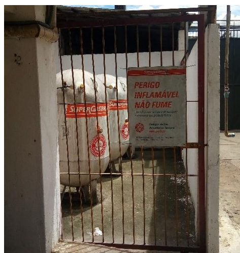
Figura 59. Armazenamento de gás. Fonte: Arquivo Pessoal.
