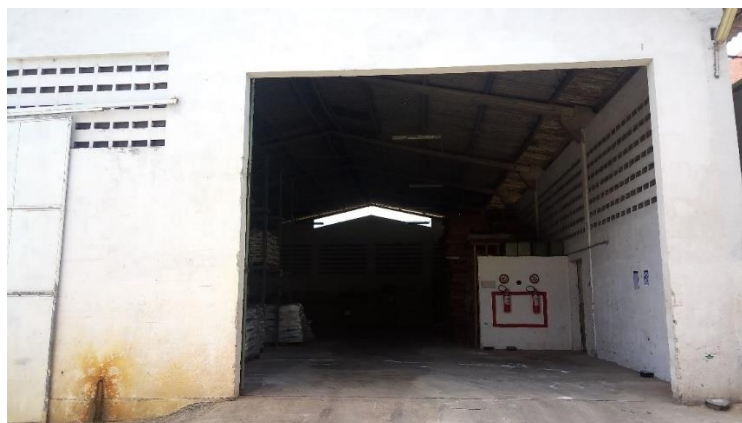
Figura 48. Vista externa do galpão de matérias primas. Fonte: Arquivo pessoal.
