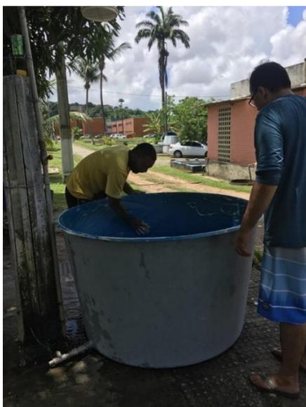
**Figura 5.** Lavagem da caixa d'água
