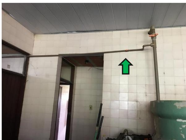
**Figura 42.** Encanação para o abastecimento de água
