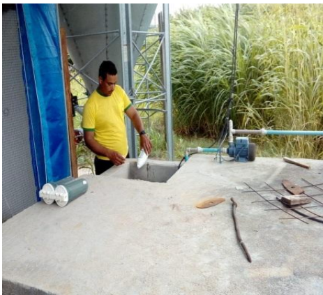
Figura 21. Tratamento da água: (A); Cloração da água (B). Filtro de limpeza. Fonte: Arquivo pessoal, 2018.
