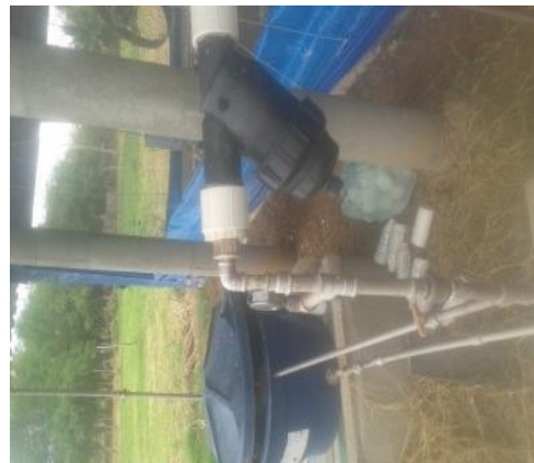
Figura 21. Tratamento da água: (A); Cloração da água (B). Filtro de limpeza. Fonte: Arquivo pessoal, 2018.
