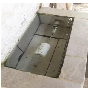
Figura 7. Parte externa do bebedouro
