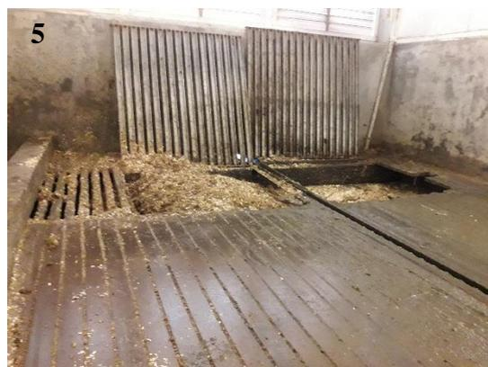
Figura 5: Canaleta de escoamento dos dejetos.
