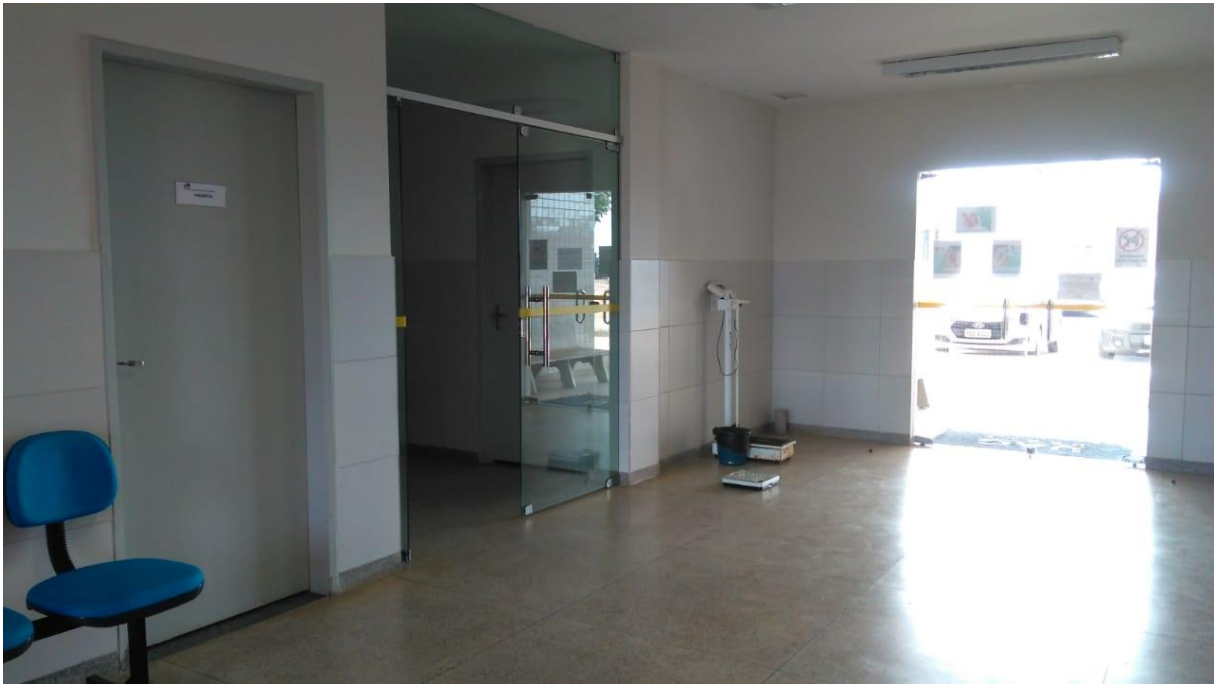
Figura 9. Salão de recepção, farmácia, corredor operacional e acesso externo do Hospital Veterinário Universitário da Universidade Federal Rural de Pernambuco, Unidade Acadêmica de Garanhuns. Fonte: Arquivo pessoal.
