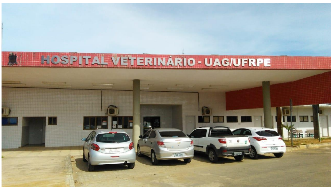
Figura 1. Fachada do Hospital Veterinário Universitário da Universidade Federal Rural de Pernambuco, Unidade Acadêmica de Garanhuns. Fonte: Arquivo pessoal.
