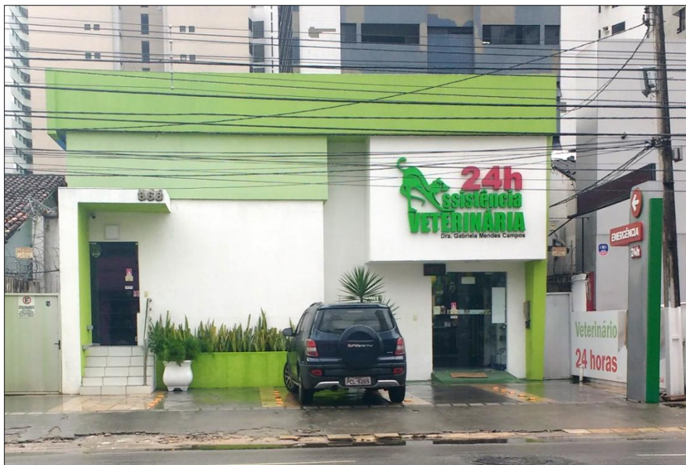
Figura 1: Vista Frontal da Clínica de Assistência Veterinária 24 horas. Estacionamento e entrada de acesso ao público (Recife – PE). Fonte: arquivo pessoal (2018).
