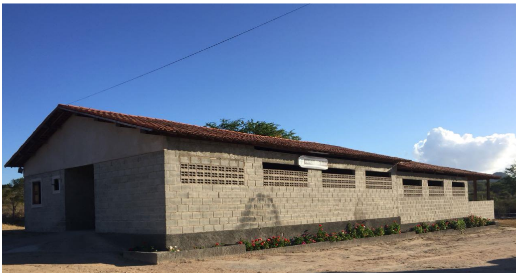
Figura 1: Pavilhão de baias. Fonte: Arquivo pessoal.
