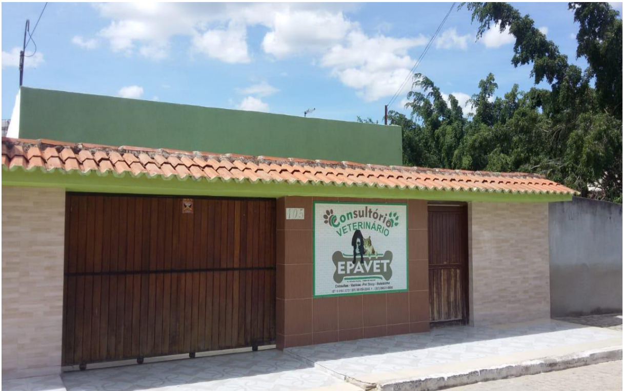
15 Figura 1. Consultório Veterinário EPAVET, fachada e entrada principal. Fonte: Arquivo Pessoal.
