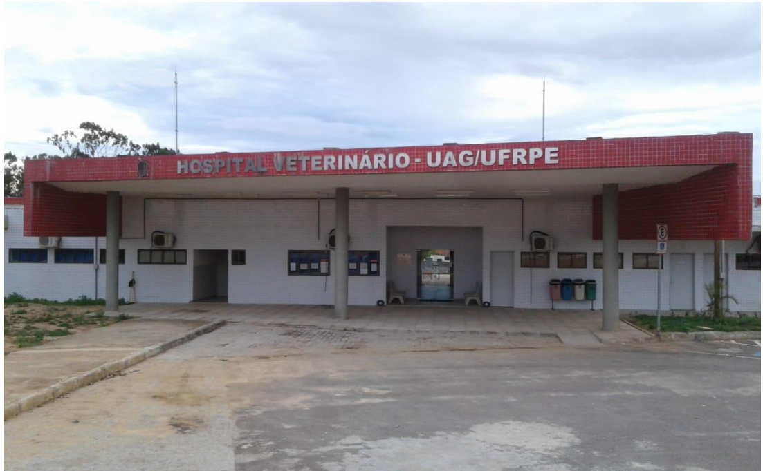
Figura 1: Da Paz, A. V. S. Vista da entrada de acesso do HVU (Garanhuns-PE). Fonte: Coleção particular.
