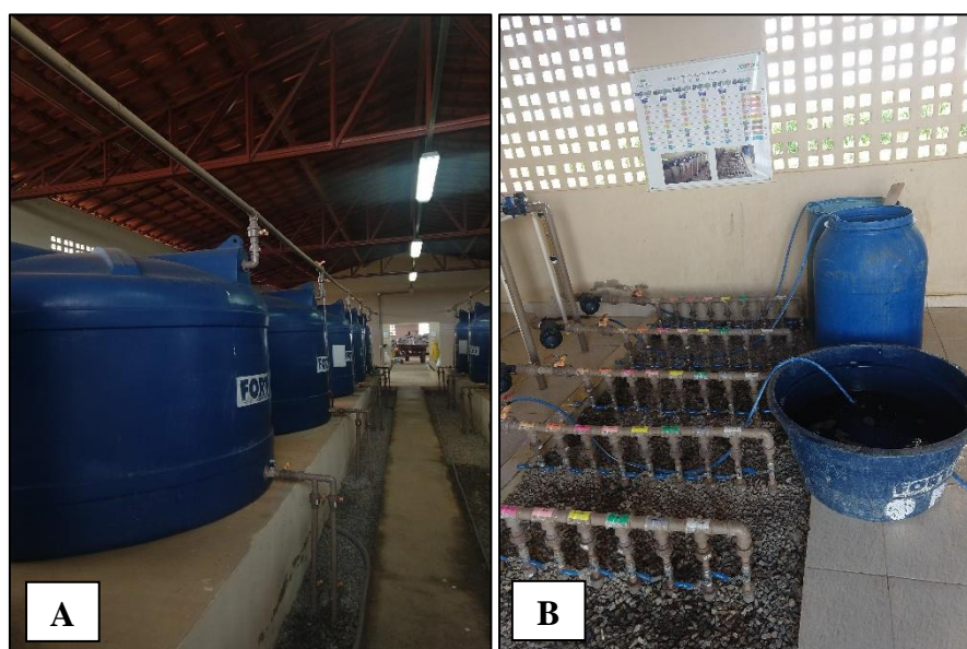
Figura 19. Caixas para armazenamento da solução de macronutrientes (A) e injeção de micronutrientes no sistema de irrigação (B), Fazenda Bom Jesus, Abaré, BA.
