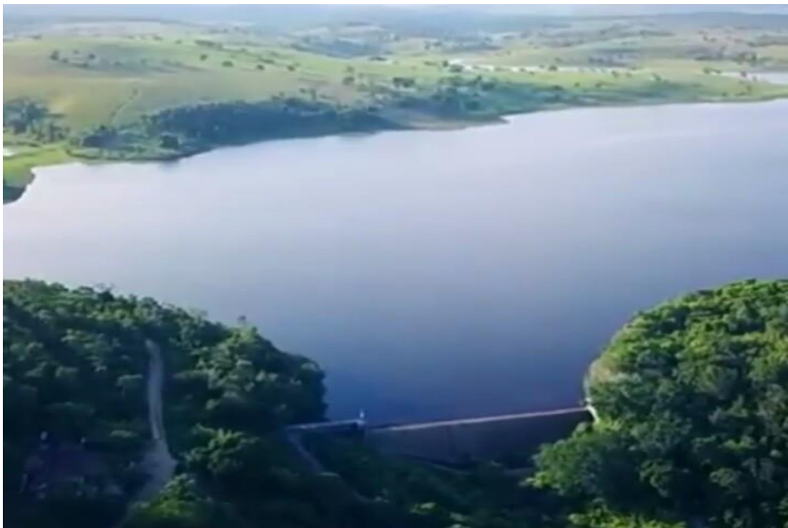
Figura 4 - Reservatório Celso Galvão (“Barragem Inhumas”).
