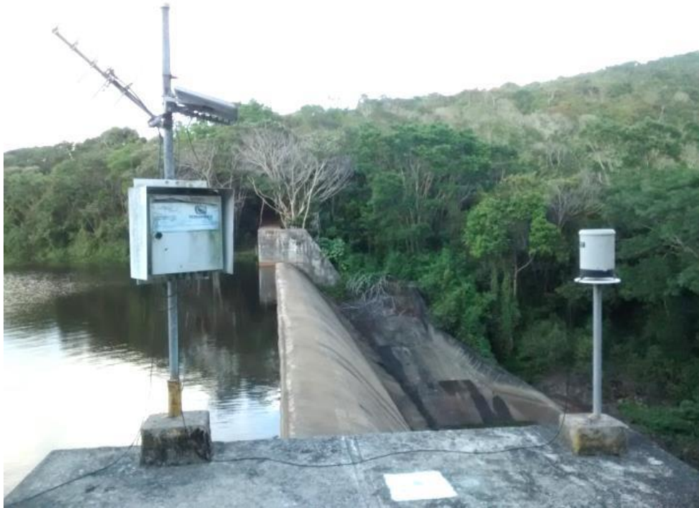
Figura 11 - Posto pluviométrico n° 512, localizado no dique de contenção da Barragem Inhumas
