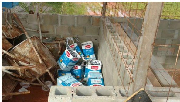
Figura 11- Latas de tintas alocadas nas baias de resíduos metálicos
