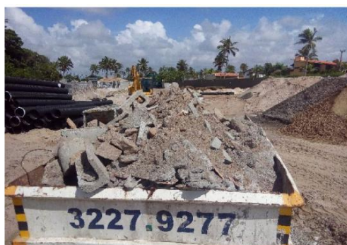
Figura 2 - Estoque do entulho de concreto e areia após a demolição
