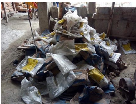
FIGURA 12 - Resíduo classe B - sacos de cimento e argamassas.
