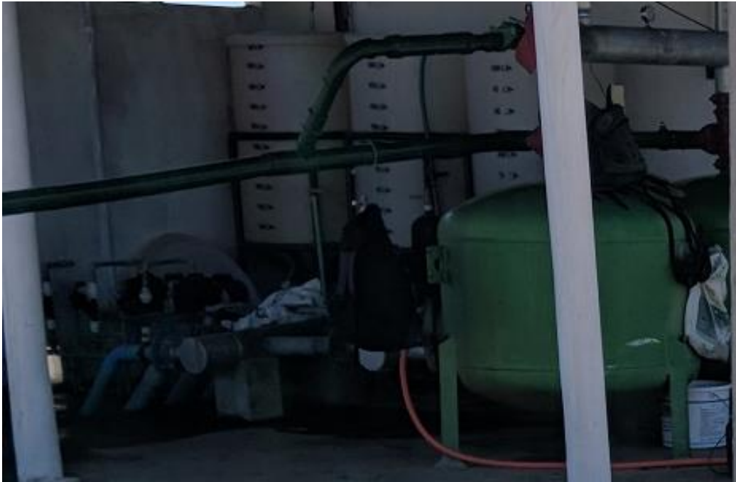
Figura 10 – Casa de mistura contendo filtro de areia e os tanques de mistura.
