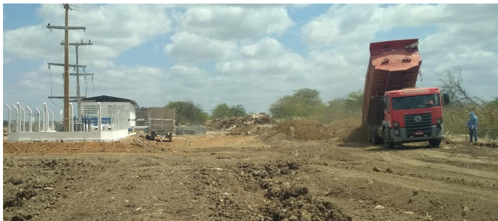
Figura 22. Vistoria em obra de aterro para construção de canal.
