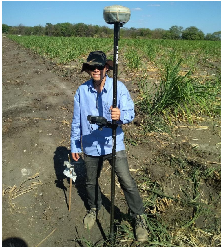
Figura 29. Locação com GPS RTK Trimble e piquete bandeira manifestando marcação do ponto.
