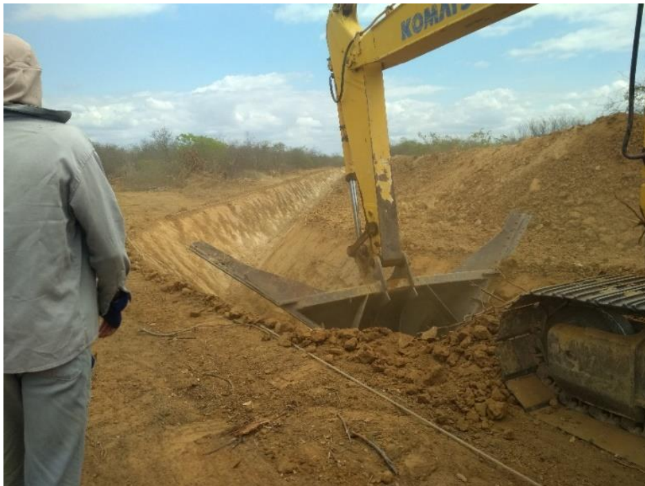
Figura 32. Abertura de dreno após marcação de piquetes de percurso e piquetes guia, com as cordas de auxílio limitando profundidade de escavação pelo operador da escavadeira.
