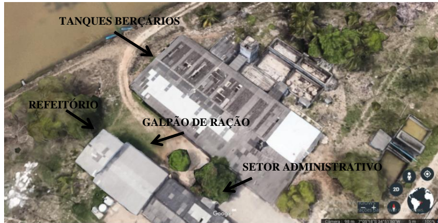
Figura 3 – Imagem aérea da estrutura dos tanques berçários, refeitório, galpão de ração e setor administrativo da fazenda Camar Aquamaris, João Pessoa – PB.
