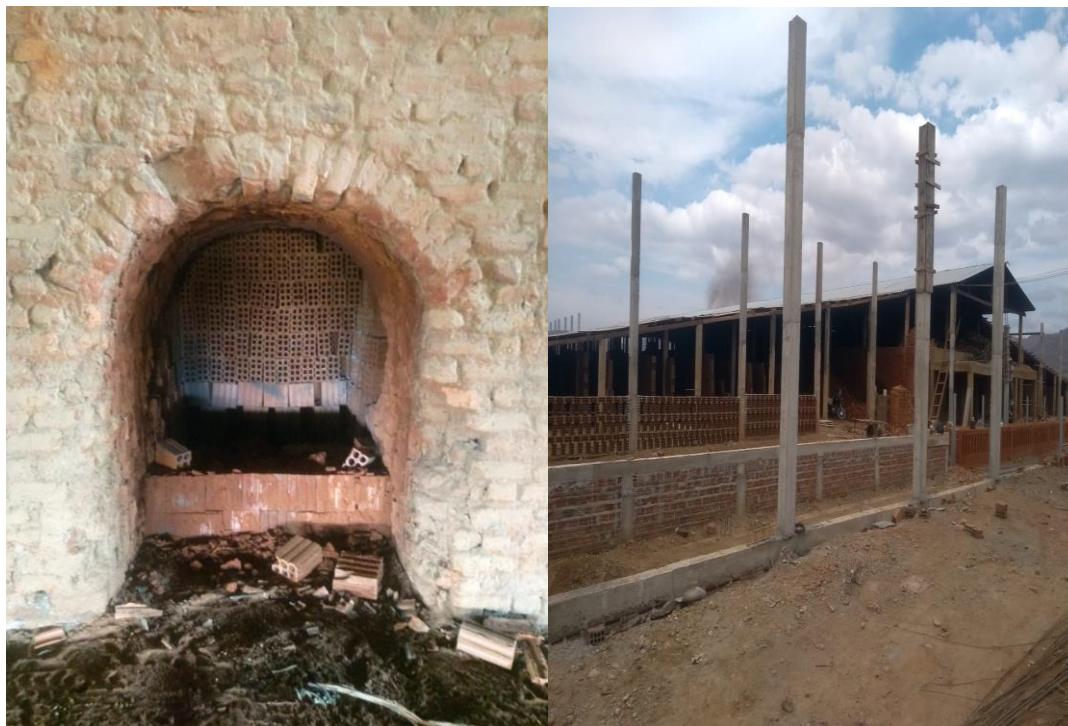
Fotografia 5: Forno para aquecimento dos tijolos e obras de ampliação da fábrica
