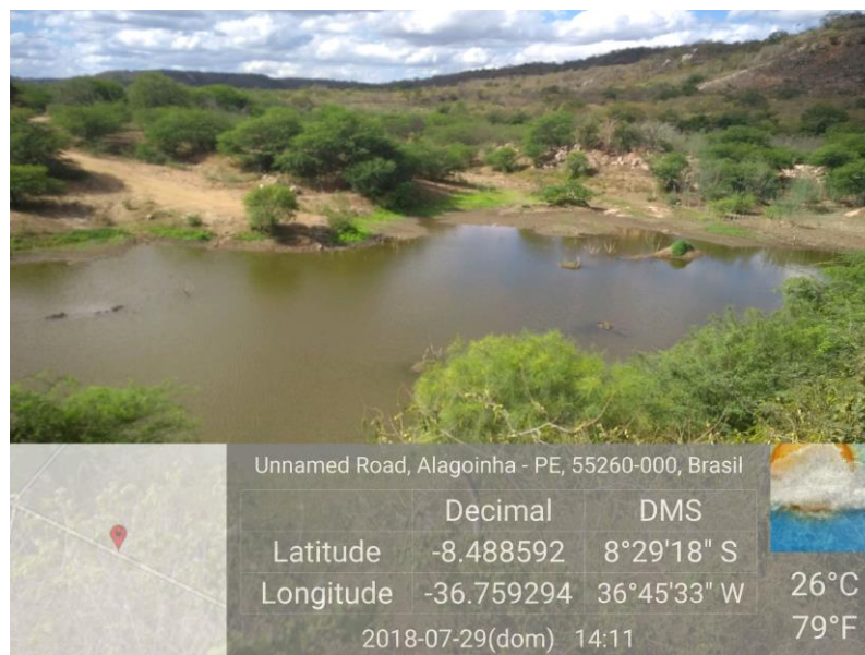
Figura 37 - Barragem do "Pé da Serra"
