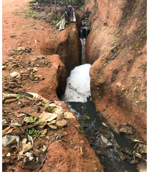
Figura 26 – Efluente líquido (esgoto) à céu aberto.
