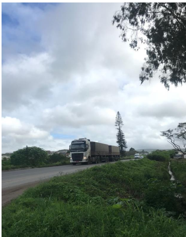
Figura 12 – Rodovia de tráfego pesado. E em suas margens, esgoto a céu aberto.
