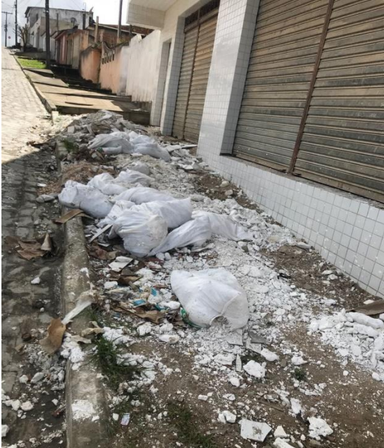
Figura 19 – Descarte incorreto de material de construção (gesso).
